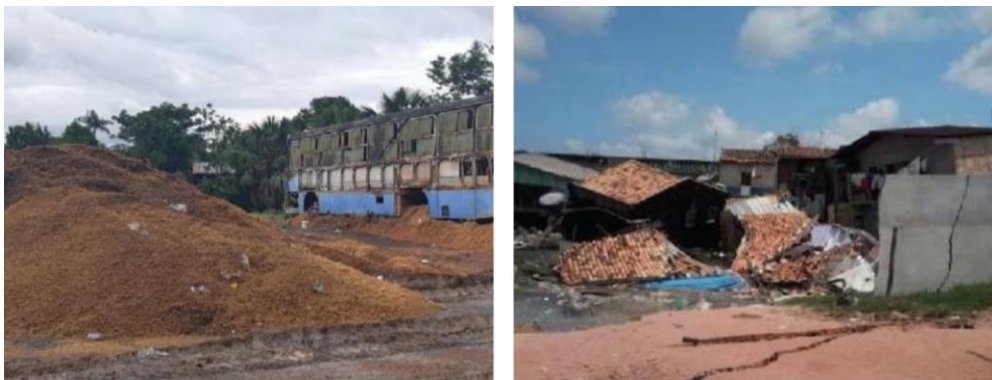
Figura 1: Descarte irregular do caroço do açaí (esquerda) e colapso de aterro não controlado em Abaetetuba/PA (direita). (fotos: Beatriz Cintra).
