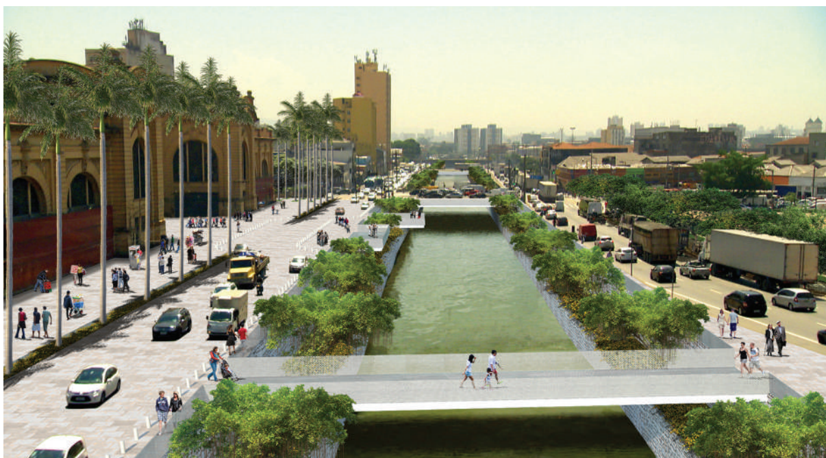
Figura 7 – Vista do Bulevar Tamanduateí
