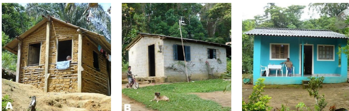
A partir da esquerda: estrutura de madeira roliça com taipa de mão; estrutura de paredes em alvenaria cerâmica e estrutura de concreto armado com vedações (fonte: Marchetti, 2009:25)
